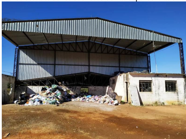
Figura 02 - Local de descarte do resíduo recebido nas dependências da usina de triagem
