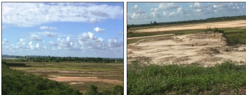
Figura 06: Indícios de processos erosivos na Ponte Aracaju- Barra de Coqueiros
